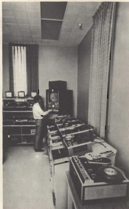
Manutenzione degli apparati RUM presso la Hewlett-Packard.
